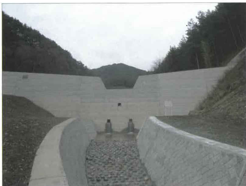
平成21年竣工 発注者：長野県犀川砂防事務所 国補通常砂防工事 仏ヶ沢砂防堰堤
